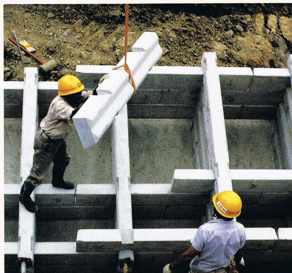
控材：D-1000, I660を一体構造とした場合の組方例
