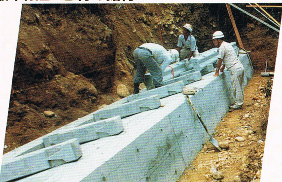
2 最下段D-C材の据付
